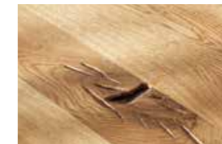
Offene Äste/Risse ausgeschliffen
